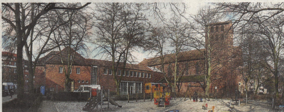
Der kleine Spielplatz zwischen Dortmund- und Hamburger Straße soll seinen Charme behalten. Allerdings werden Pfarrheim (M.) und Pfarrhaus (l.) einem Neubau weichen. Foto: Matthias Ahlke
